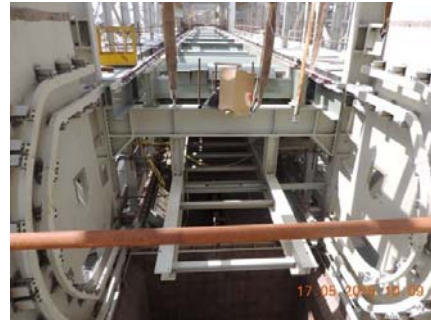
نمای ساختمان کوره- نصب Slide track ها و Curved Rail ها
