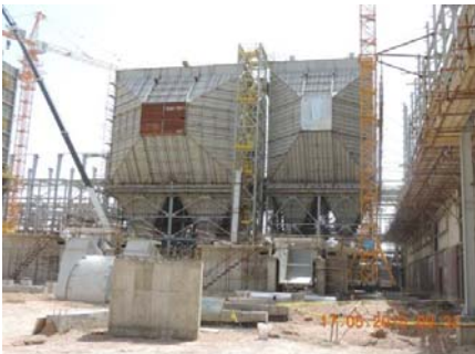
ESP ها - نصب تجهیزات
