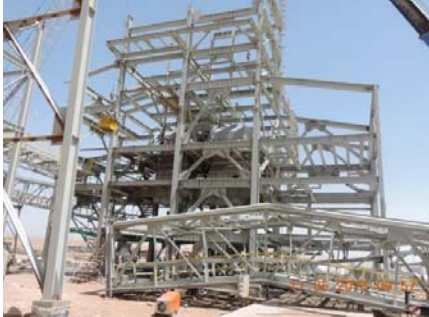
ساختمان Screening - نصب سرند ها و شوت ها
