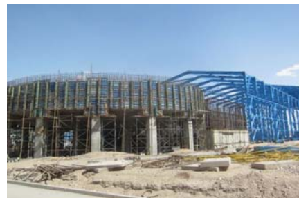
اسکلت بتنی تیکنر
