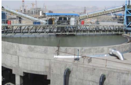
Reject Bin Line ۱
