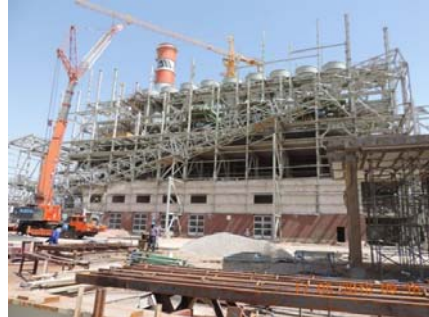
نمای ساختمان Green Pelletizing
